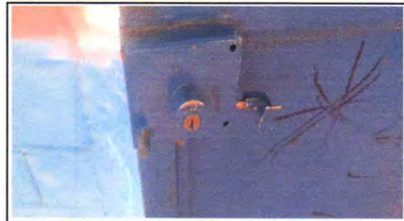
FOTO 4: Sustitución de chapa
