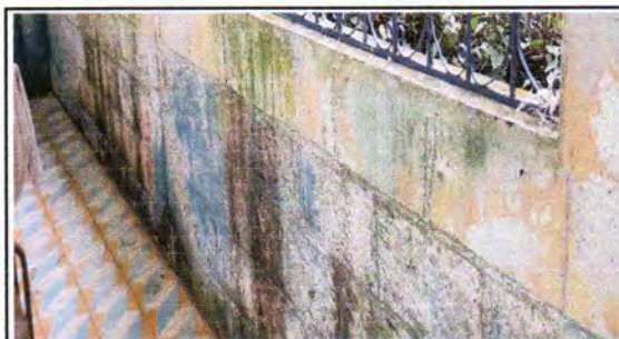
FOTO 9: PINTURA EN MUROS EXTERIORES E INTERIORES
