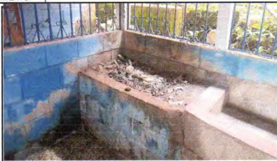
FOTO 7: Sustrucción de estufa rural (completa) incluye chimenea y plancha de metal
