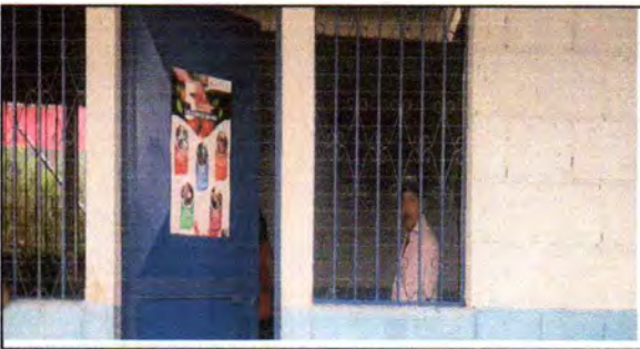
FOTO 5: Mantenimiento a balcones de metal
