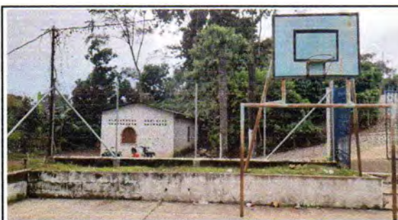
FOTO 12: Reparación de tubo hg y malla galvanizada
