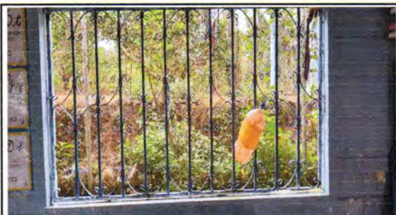
FOTO 10: Fabricación e instalación de balcones de hierro en ventana
