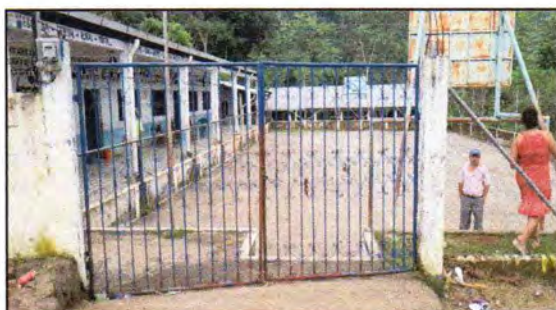
FOTO 11: Mantenimiento a portones de metal de rejas
